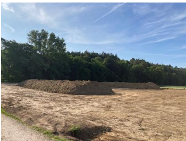
Beginn der Baumaßnahme Hochwasserschutz in Birnkofen
